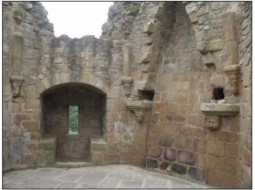
Tour du Renard La salle de l'étage avec les départs de nervures de la voûte et une embrasure à coussièges. cl. Chr. Remy
