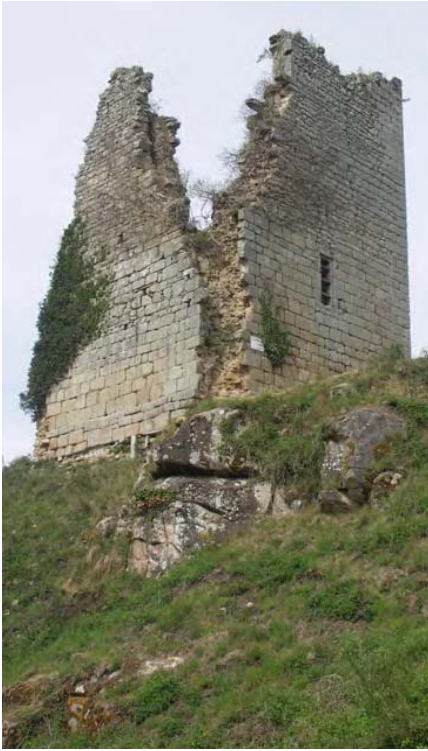
La tour quadrangulaire en 2011, avant travaux de cristallisation. cl. Chr. Remy
